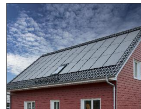
Direkt auf die Konterlatten über der Dämmung und Unterdeckbahn wurde bei diesem Zweifamilienhaus eine Tragkonstruktion für Indach-Solarmodule montiert.
