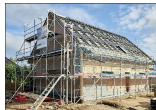
Direkt auf die Konterlatten über der Dämmung und Unterdeckbahn wurde bei diesem Zweifamilienhaus eine Tragkonstruktion für Indach-Solarmodule montiert.
